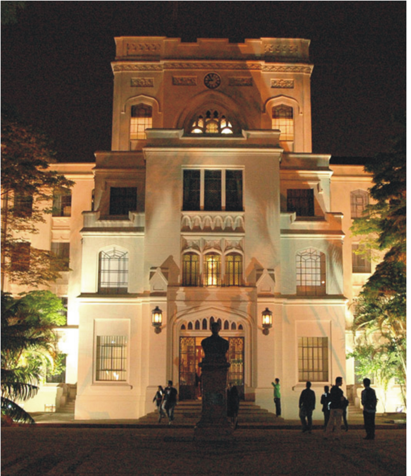
A Fachada da FMUSP restaurada: uma das conquistas do Projeto de Restauro
