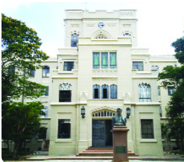
A fachada restaurada da FMUSP
