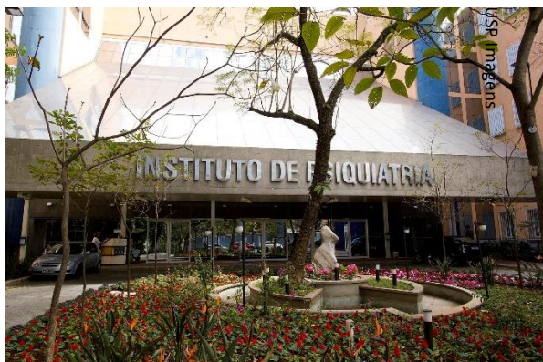
Fachada do IPq
