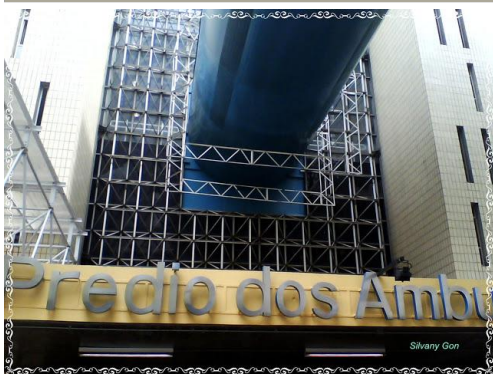
Prédio dos Ambulatórios do ICHC
