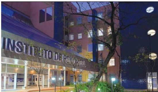
Fachada do edifício principal do Instituto de Psiquiatria
