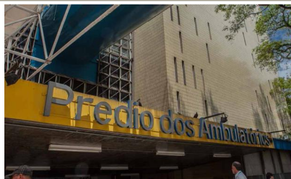
Prédio dos Ambulatórios do ICHC
