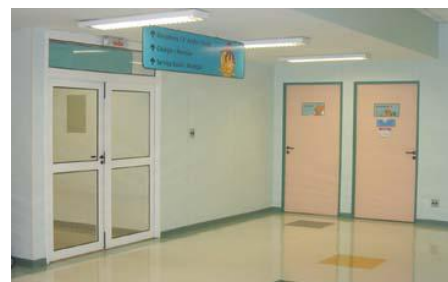
Área dos Ambulatórios, já reformada
