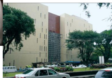
Prédio dos Ambulatórios
