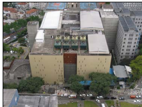
Área do Prédio dos Ambulatórios
