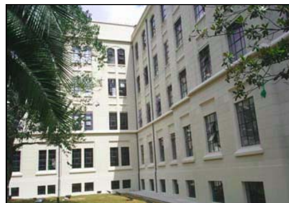
Fachada Lateral da Faculdade restaurada
