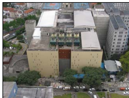
Área do Prédio dos Ambulatórios
