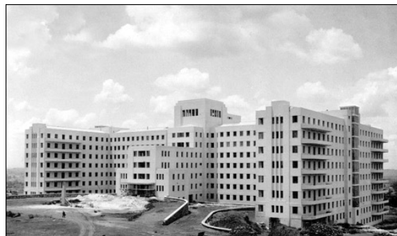
Hospital das Clínicas em construção – 1942
