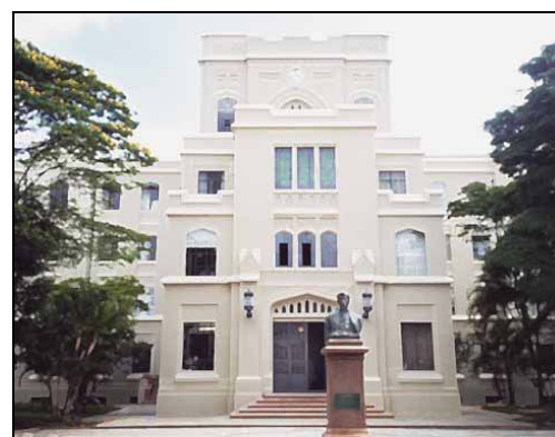
Fachada Frontal da Faculdade restaurada
