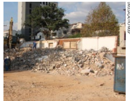
Obras do novo Hospital de Cotoxó
