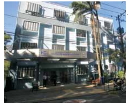
A fachada do Serviço também passou por reformas
