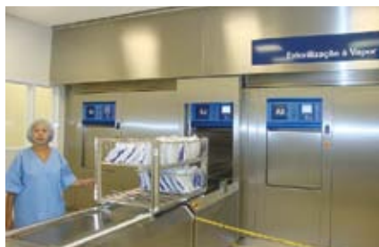
Central de Material Esterilizado
