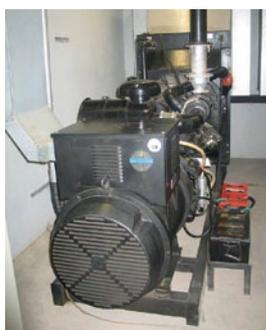
Um motor de caminhão faz funcionar o gerador elétrico.
