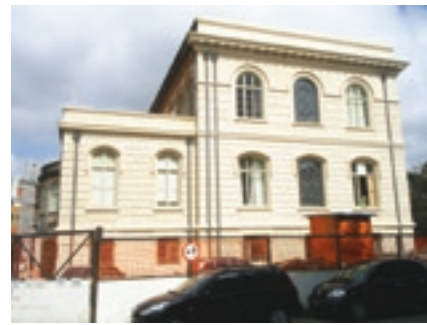
Fachada lateral depois do restauro.
