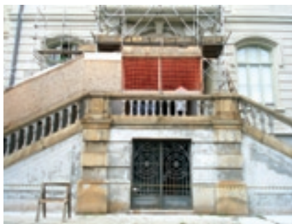
Restauro da entrada do IOF.
