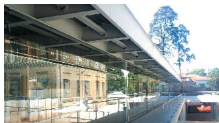
Pavilhão de Serviços
