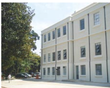
Fachada nos fundos do edifício principal
