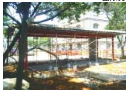
Iniciadas as obras da nova portaria da Rua Teodoro Sampaio
