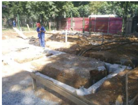
Portaria em fase final
