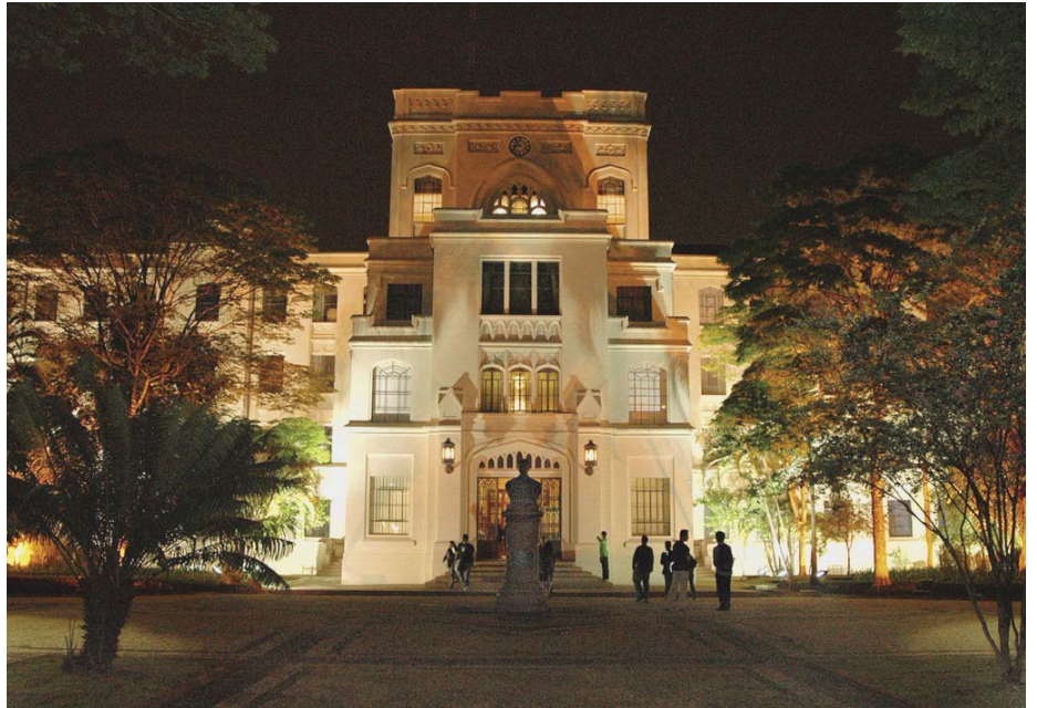
A Fachada da Faculdade restaurada: uma das conquistas do Projeto de Restauro
