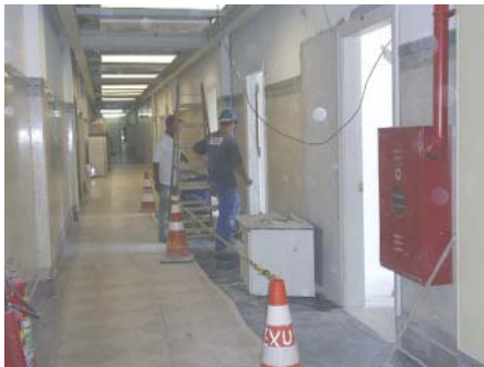
Corredor adjacente em reforma
