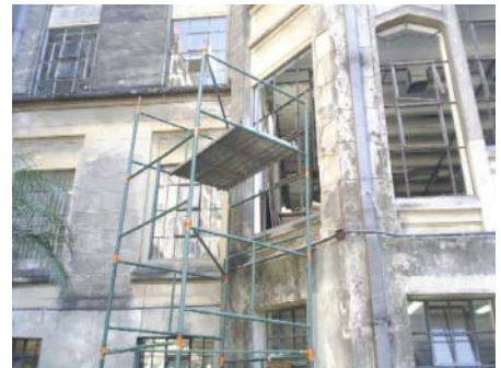
Fachada lateral em obras
