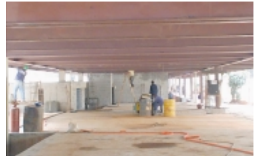
As obras do Pavilhão de Serviços
