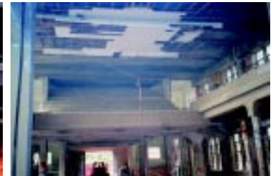
Acima, a fachada original do Teatro, que será restaurada. Abaixo, esq. , a Método Engenharia está rebaixando o solo da platéia para melhorar a inclinação das cadeiras. Ao lado, paredes e forro já foram descascados e receberão novos revestimentos.
