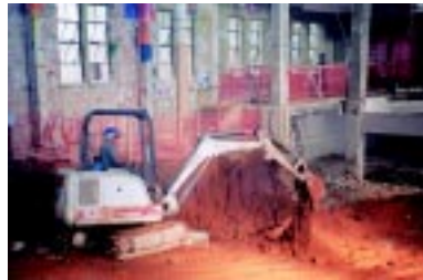
Acima, a fachada original do Teatro, que será restaurada. Abaixo, esq. , a Método Engenharia está rebaixando o solo da platéia para melhorar a inclinação das cadeiras. Ao lado, paredes e forro já foram descascados e receberão novos revestimentos.
