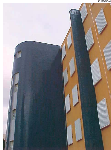
Fachada do IPq, já em fase de finalização da reforma e com nova pintura.
