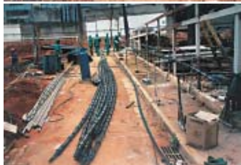
Foto 1: Remoção de terra com retroescavadeira para abastecimento de caminhão.
