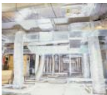
Obras do novo Centro de Bioterismo da Faculdade de Medicina da USP.
